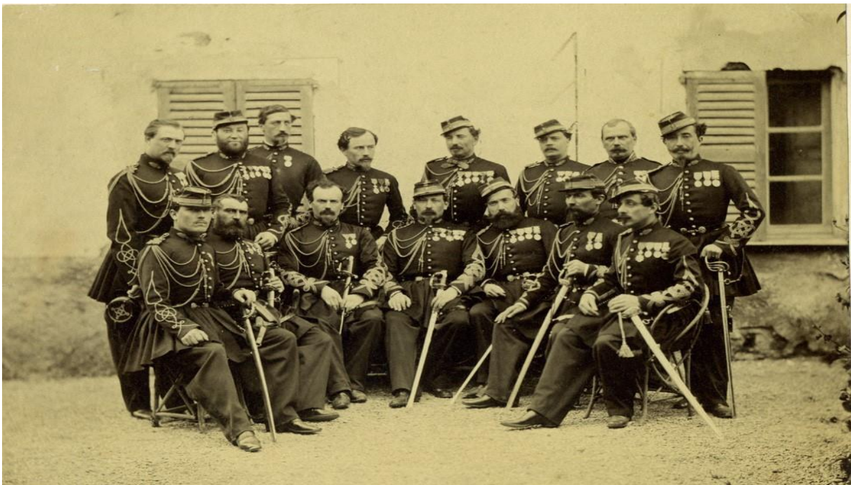
Photo des Officiers du bataillon des zouaves de la Garde prise à Nice en Mai 1860
